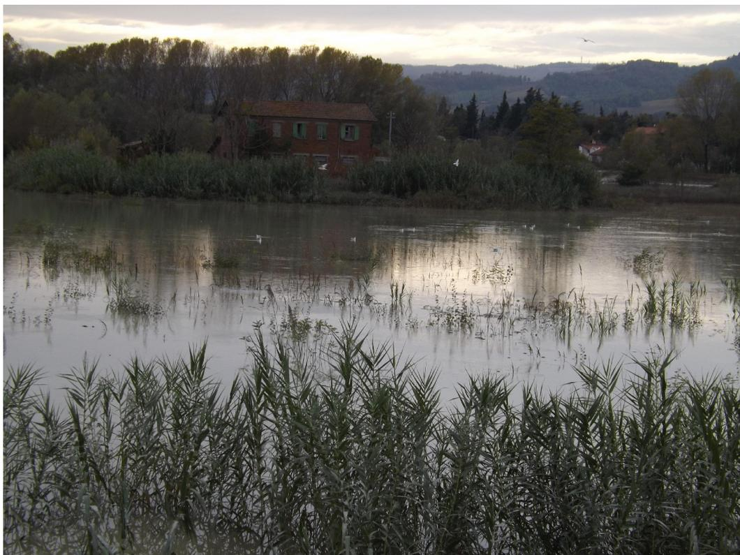
Percorso: L'opera, è una vera e propria cassa di espansione realizzata in località Cà Bianchi a monte di Cesena, è localizzata in sponda destra del fiume Savio, separata dal medesimo mediante un argine.
