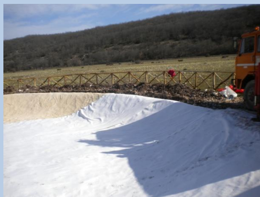
2 Deposizione teli impermeabilizzanti
