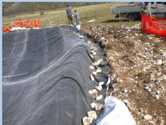
3 Deposizione teli impermeabilizzanti
