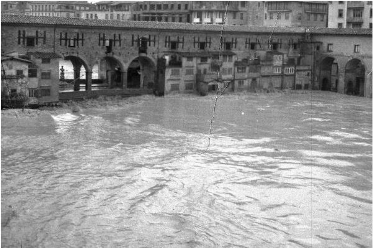
Ponte Vecchio a Firenze durante l'alluvione del 1966. http://www.raistoria.rai.it/gallery-refresh/lalluvione-di-fiorenze/823/0/default.aspx
