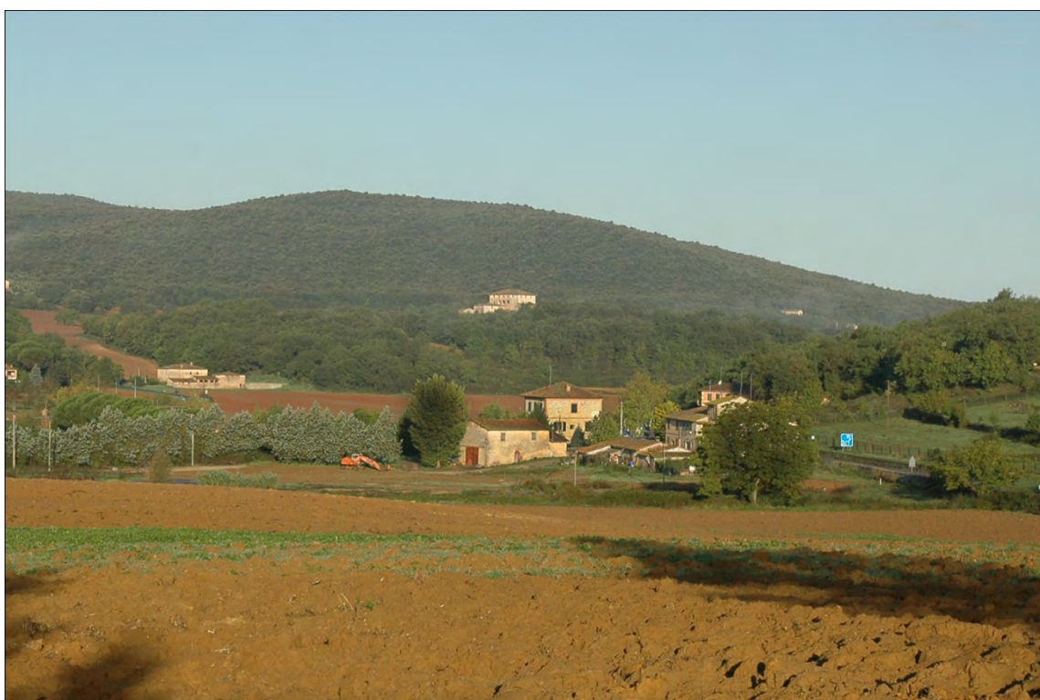
Figura 5: Veduta dalla strada dell'aggregato rurale "Il Ceppo" dopo l'intervento aspirapolvere di demolizione
