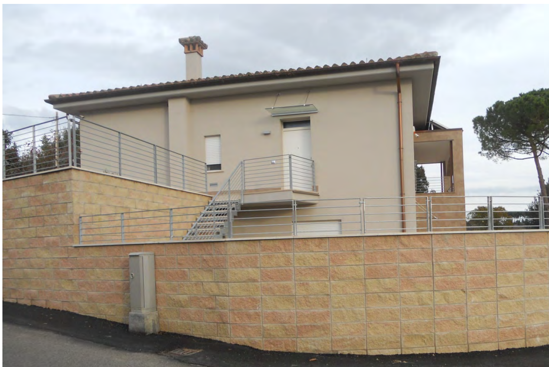
Figura 6: Edificio realizzato in area NET AR46 Malizia 1 con l'apporto dei crediti edilizi (fase di cantiere, verde in allestimento)
