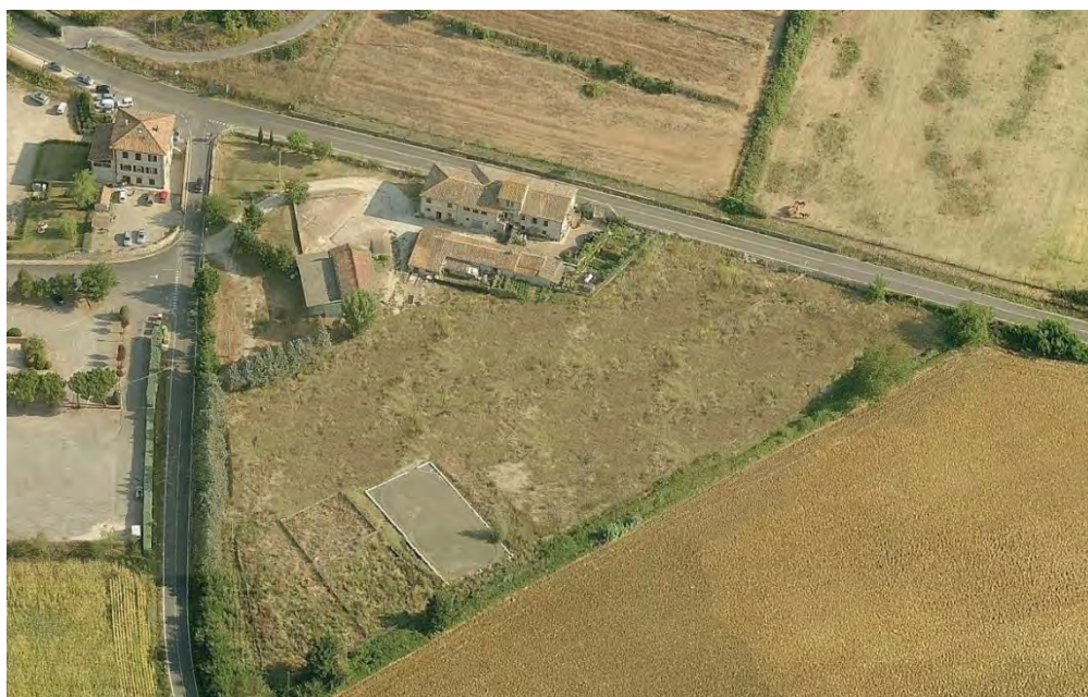
Figura 3: Veduta aerea dell'aggregato rurale "Il Ceppo" dopo l'intervento aspirapolvere di demolizione
