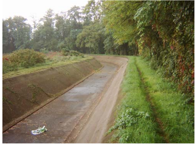
Canale irrigazione Villorresi
